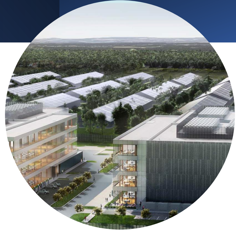
Le Centre de traitement de données QScale (Lévis)
