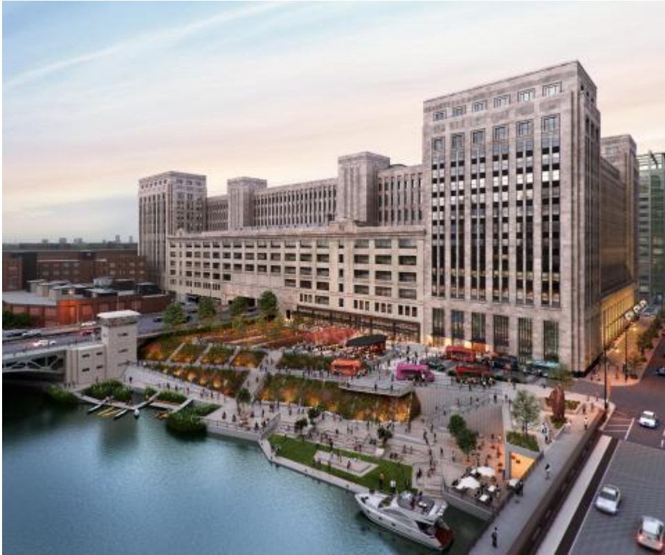
L'ancien bureau de poste de Chicago, maintenant alimenté par une « batterie de glace »
