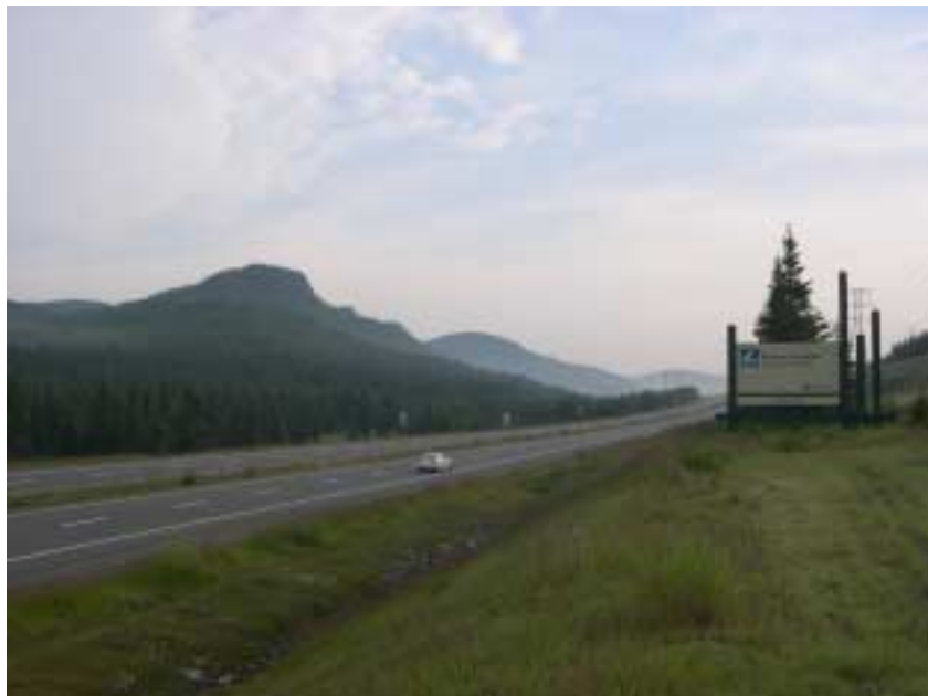
Photo 1 : Route 175 (section à chaussée séparée)
