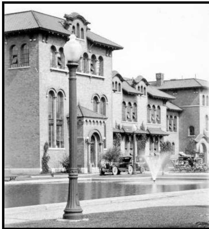
Figure 1 : Photographie de l'usine de filtration Atwater dans les années 1930
